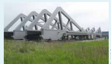
Die Stahlkonstruktion der vier Klappen wurde auf einem Vormontageplatz in Wilhelmshaven vormontiert.
