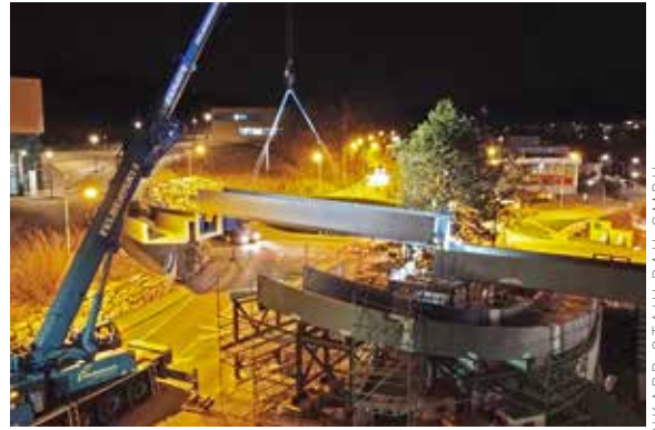
FOTOS_RCR ARANDA PIGEM VILALTA ARCHITECTES, BIEDENKÄPP STAHLBAU GMBH
