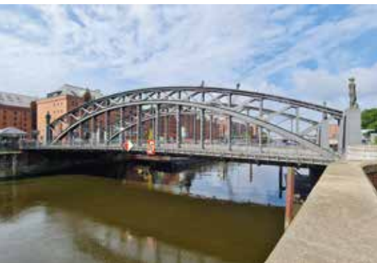
Hamburg ist mit ca. 2.500 Brücken, im Bild die Brooksbrücke, die Stadt in Europa mit den meisten Brücken.
