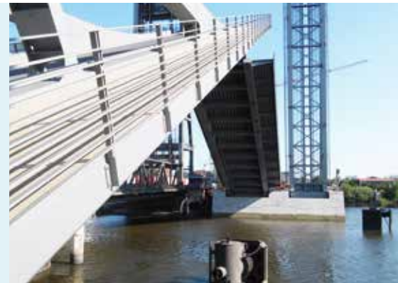
Bei der neuen Rethebrücke vergrößerte sich die Schifffahrtsbreite um 20 Meter auf 64 Meter bei einer uneingeschränkten Durchfahrts Höhe.
