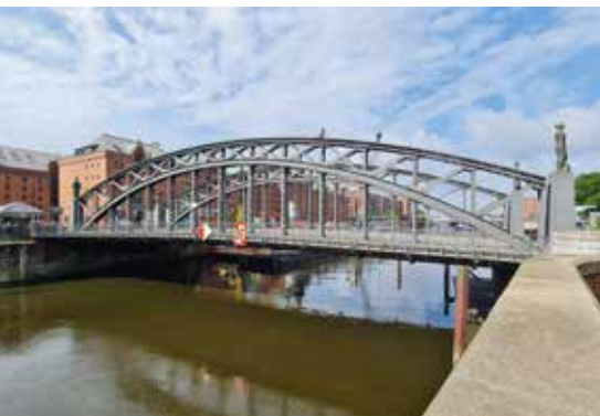
Hamburg ist mit ca. 2.500 Brücken, im Bild die Brooksbrücke, die Stadt in Europa mit den meisten Brücken.
